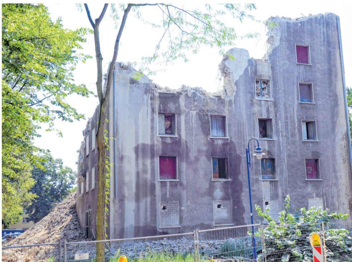
Der Abriss des Bunkers Laar nervte die Menschen monatelang. Jetzt soll dort ein Park entstehen.
