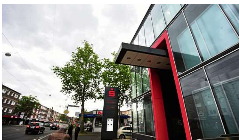
Die Filiale am Friedrich-Ebert-Platz in Aldenrade wird derzeit um einen Anbau erweitert.
